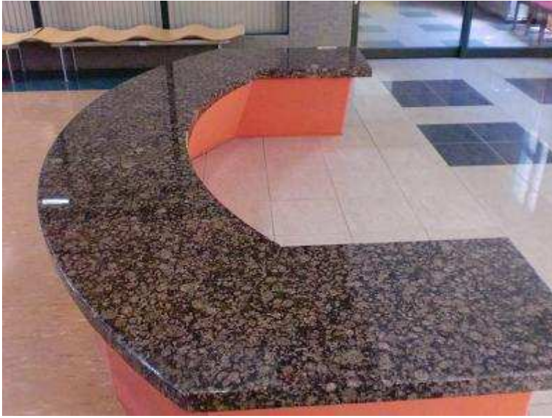
2004年施工 東大阪大学 研究棟 （石種）バルチックブラウン:フィンランド産
